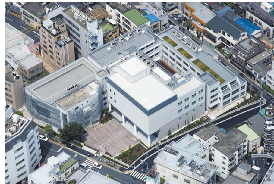
① A棟 Building A ② B棟 Building B ③ C棟 (第7ホール) Building C ④ D棟 (事務室・スタジオ) Building D
